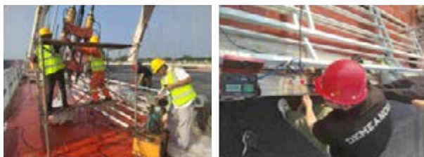
图：钢拱肋结构吊杆张拉监测
