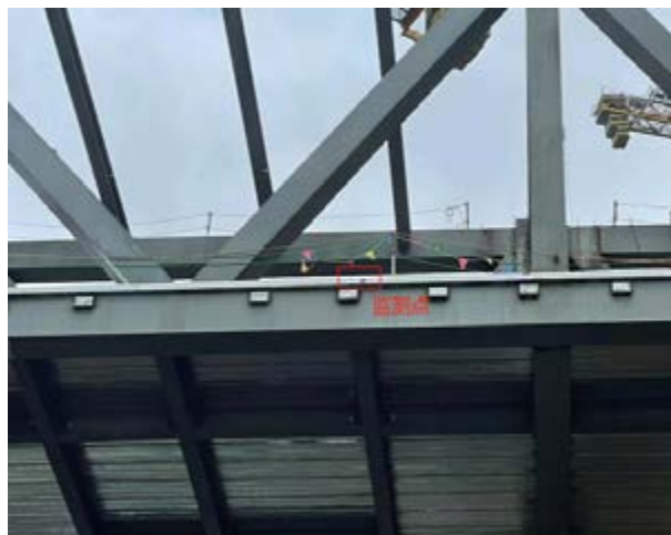
图 18 沉降观测点布置
