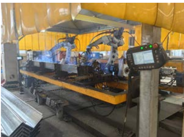
屋面梁机械手自动焊接 1
