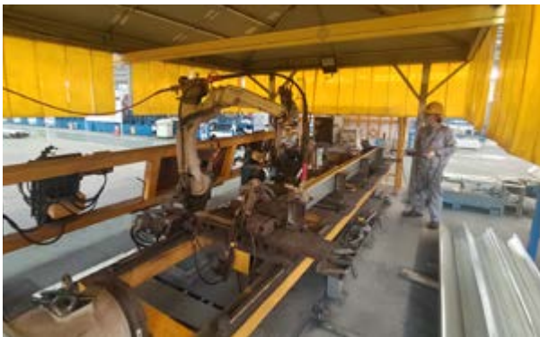
箱式房立柱机械手自动焊接 2
