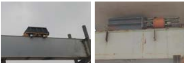
钢箱梁水平顶推施工图片
