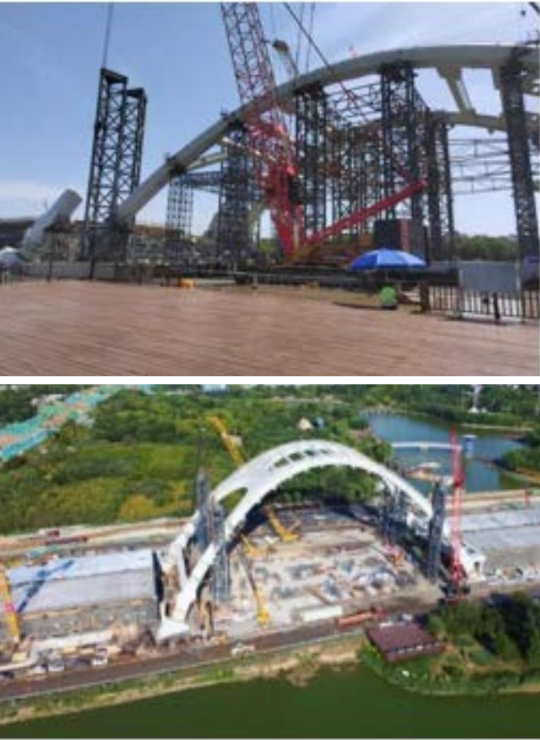
图 19 临时提升塔架图片 1
