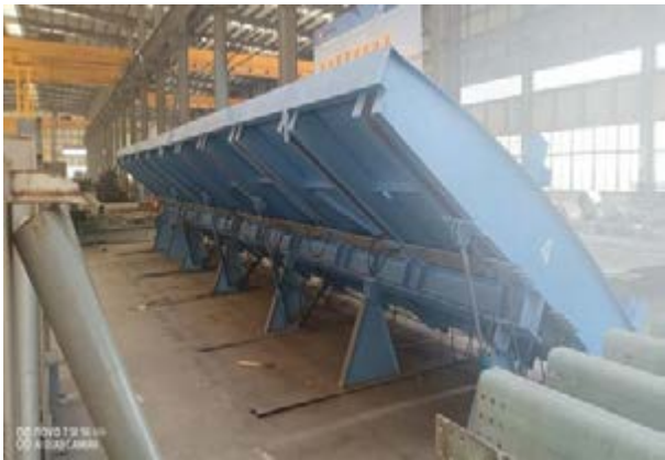
图：钢箱桥梁 U 型肋（板肋）焊接装配式胎架示意图
