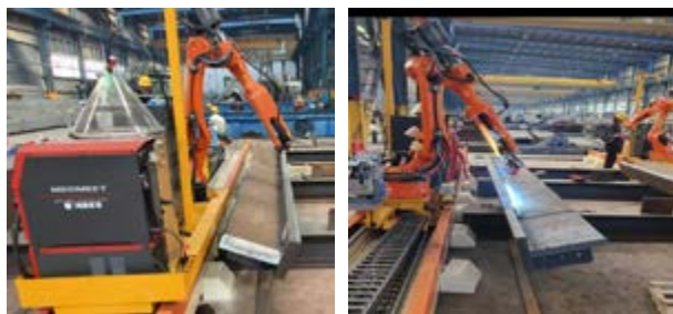
图 11 机器人焊接实体图
