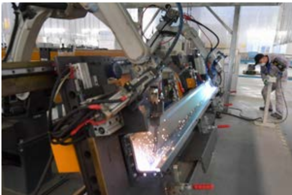
箱式房立柱机械手自动焊接 3
