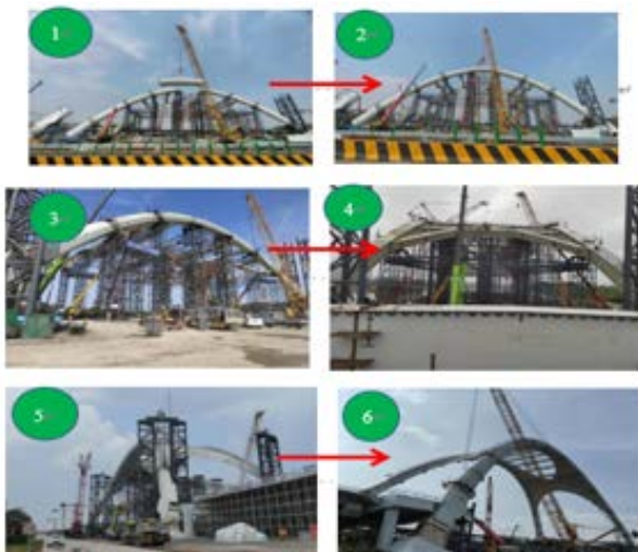
图：钢结构吊装过程监测
