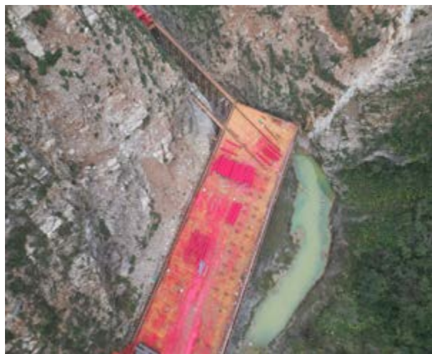
图 12 狭仄的运梁通道
