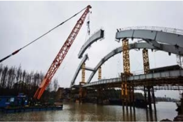
图 19 钢拱肋单件吊装安装法
