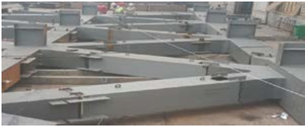
图 8 平行桁架的分层实体预拼装
