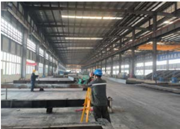
项目加工现场测控
