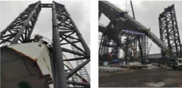
图 19 临时提升塔架图片 2
