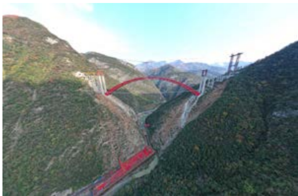
图 9 东溪河特大桥
