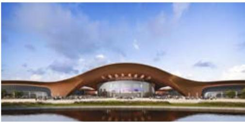
中建研科技工程咨询设计院幕墙院负责本项目的幕墙设计，建筑屋顶、檐口、立面转角等部位大量的双曲面结构，呈现出了柔和流畅的视觉效果，同时对于设计、制作，以及安装工艺等方面也提出了挑战。幕墙设计团队在不断尝试与创新中，通过空间曲面表皮 BIM 模型及计算分析，协助建筑师优化幕墙分格，从建筑效果、使用功能、建设成本等多方面提出合理化建议，完成了安全可靠、结构体系合理且经济的幕墙设计，实现了通过相互连接的轮廓线条和几何图形来体现空间互连关系的建筑设计理念。
