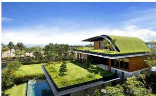
覆盖着植物和植被的绿色的屋顶和墙壁它们可以提供多种环境、社会和经济效益，有助于创造更可持续和宜居的建筑环境。而近些年发展起来的植被混凝土，有力支撑了绿色屋顶的推广。绿色屋顶在合适的条件下能够实现安全防护与生态绿化一体化，具备三重防护的功效。
