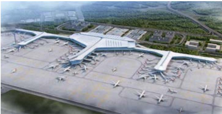
近日，中建二局安装公司参建的太原武宿国际机场三期改扩建工程T3航站楼中心区主楼项目已具雏形，现场400余名建设者正在全面推进钢结构主体冲刺建设。项目建筑面积为26.7万平方米，总用钢量约为3.2万吨，最大跨度达80.5米，建成后可满足年旅客吞吐量4000万人次、货邮吞吐量30万吨的目标。
