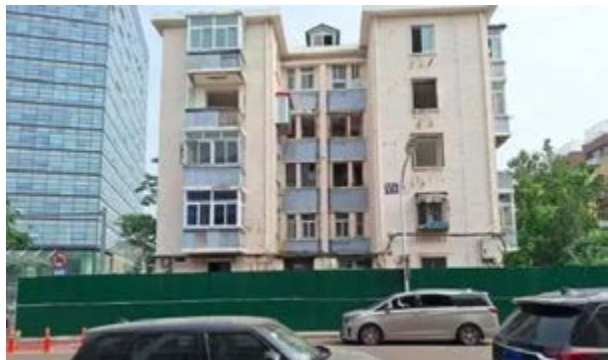
图 1 桦皮厂胡同 8 号楼拆除前外立面（图片来源：新街口街道）
