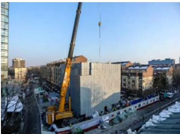
图 4 桦皮厂胡同 8 号楼施工中（图片来源：新街口街道）
