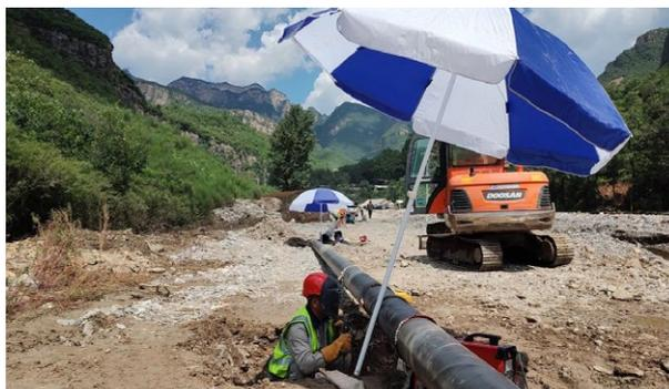
机施集团负责的 2.4 公里应急管道和三标段近 8 公里中水管道在整个施工线路上环境最为复杂、施工条件最为困难，特别是 2.4 公里应急管道是整个工程能否按时完工的关键。2.4 公里的山路里，通往施工现场的道路全部被洪水冲断，沟谷和转弯近 20 处，从陈家坟村北塘坝至循环经济产业园海拔高差达到 90 多米。为抢出时间，机施集团抢险突击队的挖掘机在进场时，沿线路纵向排开，前边开路后边挖槽，分工协作，一点一点从山下向上掘进，为应急管线敷设做好准备。
