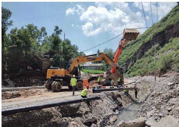
8月8日凌晨，机施集团发起佛子庄战役。机施集团连夜联络厂商定制TPEP钢管和水泵，连夜调集80多名突击队员、100多台套机械设备跑步进入佛子庄乡山区。当天上午又接到紧急通知，敷设管道由明敷改为开挖2米深沟槽埋设，施工量的增加使工期变得更加紧张。
