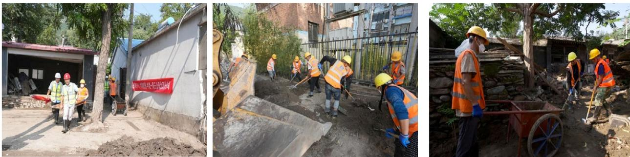
在大型机械设备无法进入的抢险段落，使用铁锹、铁铲等工具进行滑坡物清理、道路清淤等工作。截至目前，已完成6户清淤任务，清理面积共计366平方米，清理淤泥65立方米，用实际行动全力推进灾后重建。
